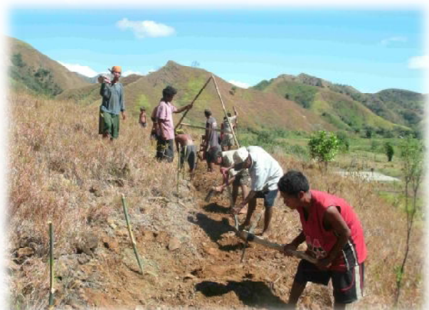
カマンブガン村でのスウェイル掘削
